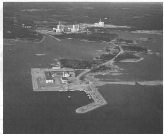
SFR処分場の全景
