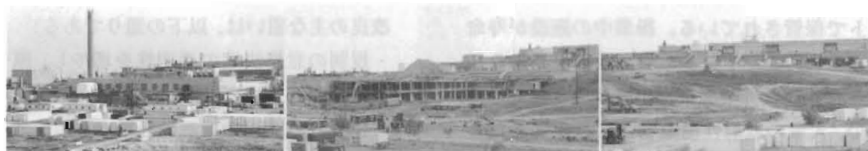
図2 771号建屋は2004年に解体が完了
