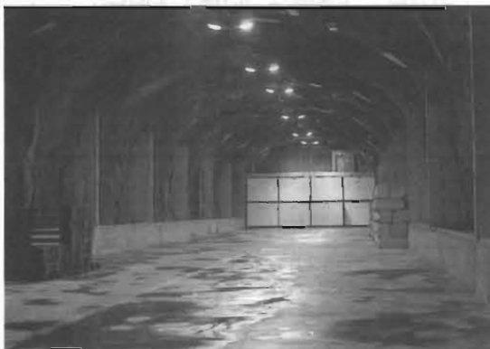
地下トンネル型貯蔵室への定置 (中レベル放射性廃棄物)
